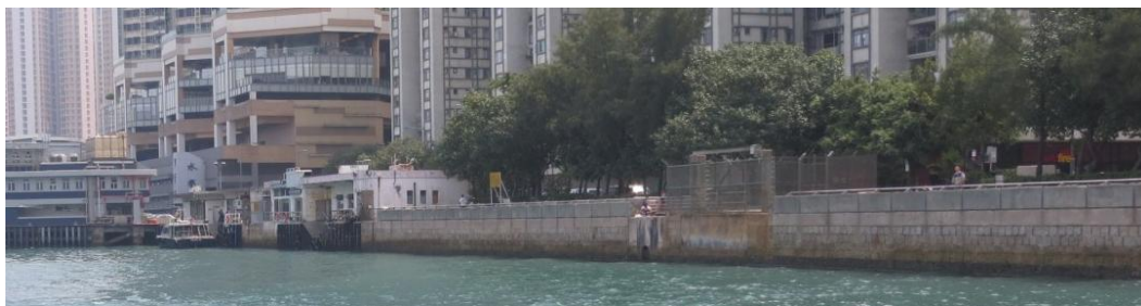
西灣河碼頭一帶的垂直混凝土牆式海堤
