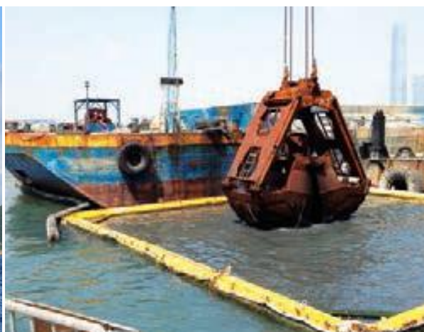
在進行疏浚的位置圍起隔泥幕，控制沉積物的飄散範圍
