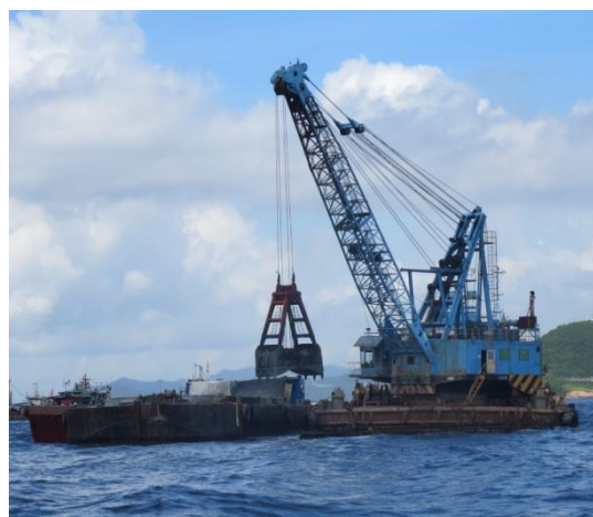
浚挖海床沉積物
